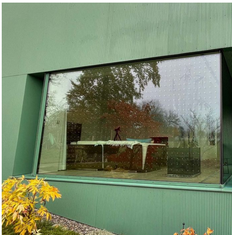
Abbildung 6: Beispiel Vogelschlagschutz an Glasfassade
